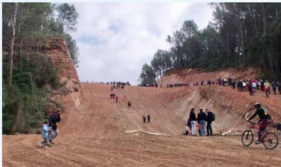
Habitants rassemblés à Colobers, en Catalogne, le 15 janvier 2012, pour assister à la destruction massive entraînée par la construction du premier segment du gazoduc MidCat.
