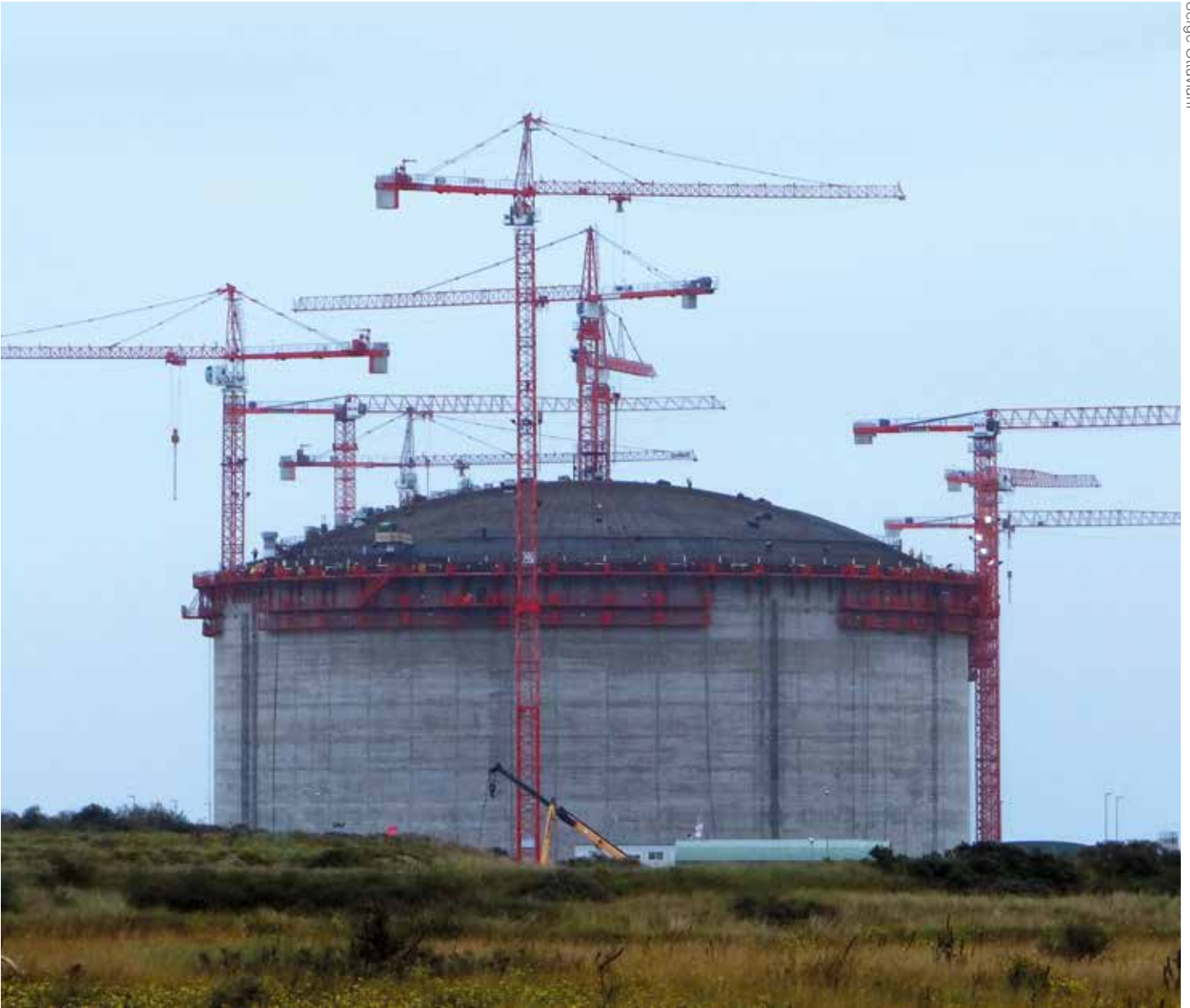
Le chantier du nouveau terminal méthanier d'EDF à Dunkerque
